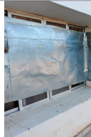
ترميم ادارة الانشاءات
