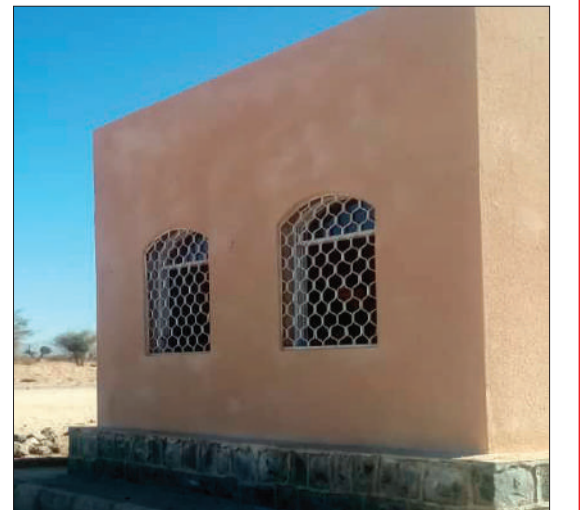
بناء محطة ارساد تعز
